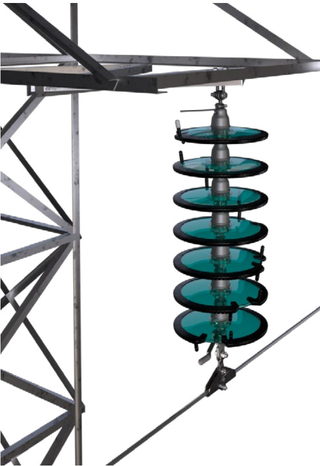
Рис. 25. Установка ГИРМК-110 на промежуточной опоре
